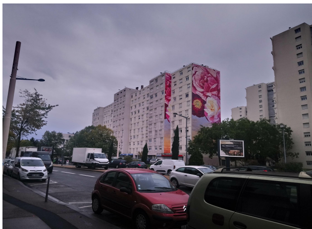
Photo 7 : Bâtiment connu pour sa fresque des roses réalisée par les artistes CitéCréation en 2011. Démolition prévue en 2022. Avenue Paul Santy.
